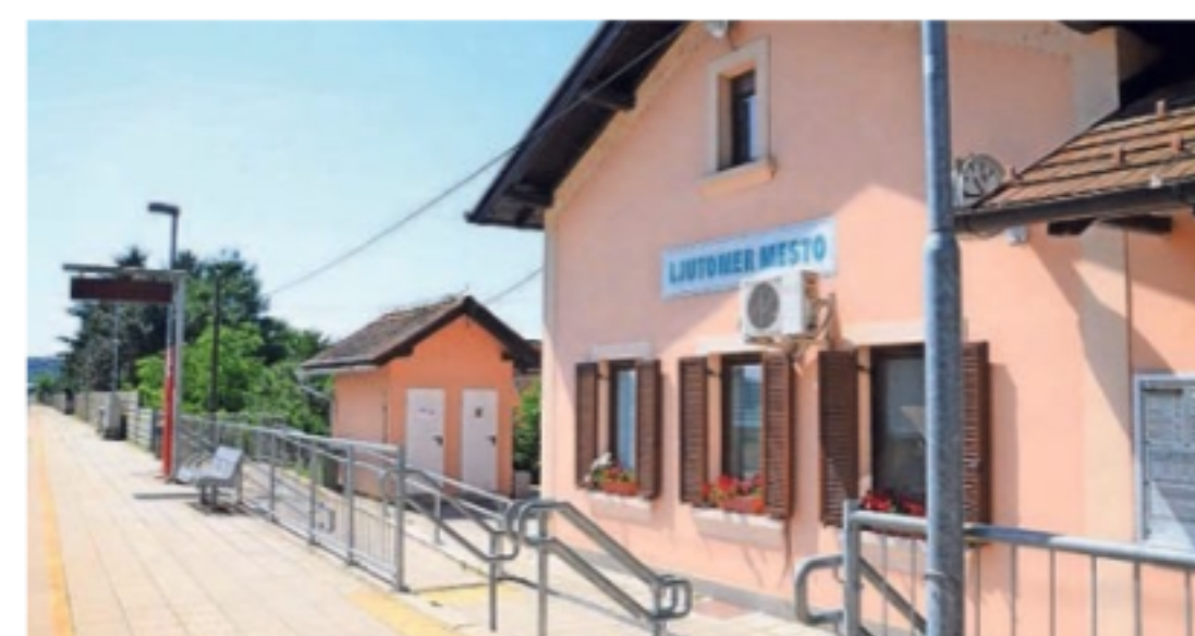
Dobila sta obvestilo, da se pri železniški postaji nekaj nenavadnega dogaja. FOTO OSTE BAKAL
